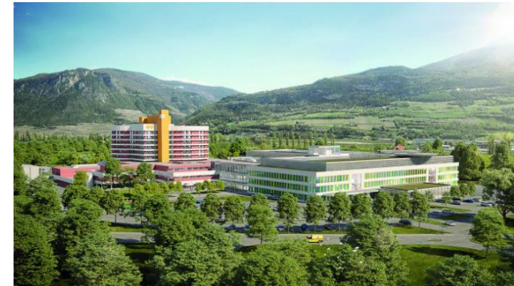
Extension de l'hôpital de Sion
